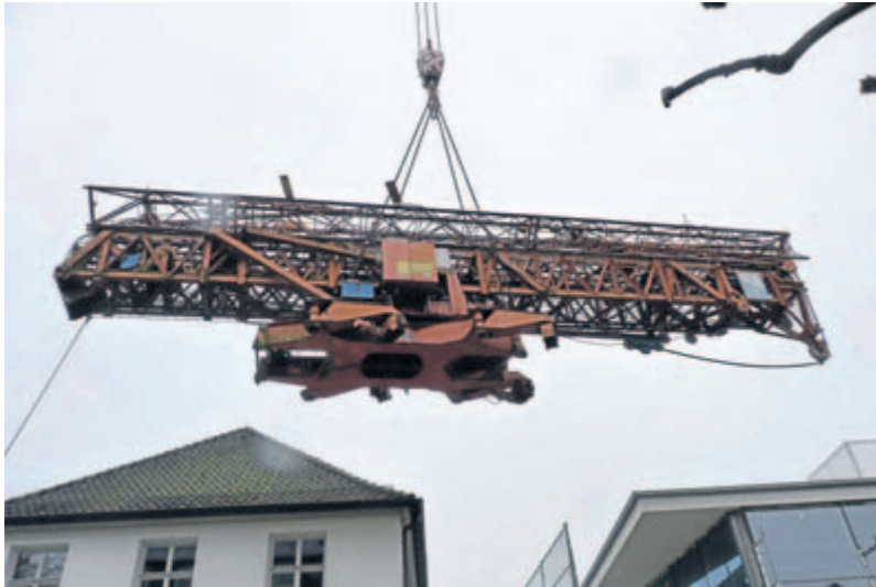
Der Kran schwebte über den Menseneubau in die Königstraße.
